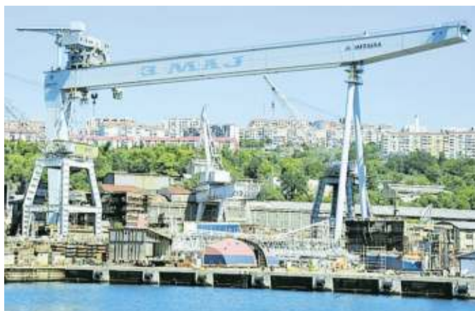
Un'immagine del cantiere Tre Maggio a Fiume. novilist.hr
