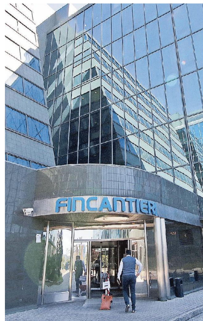
IL PALAZZO DELLA MARINERIA OSPITA IL MAGGIOR NUMERO DI UFFICI FINCANTIERI A TRIESTE
